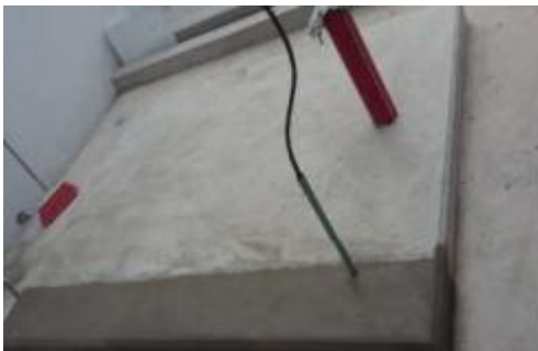
Fabricación de bases de concreto donde se montará transformador y banco de capacitore.
