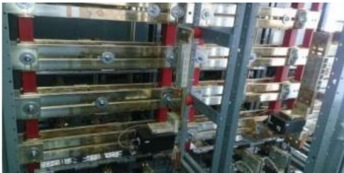
Conexión de barras y ajustes internos en tableros.
