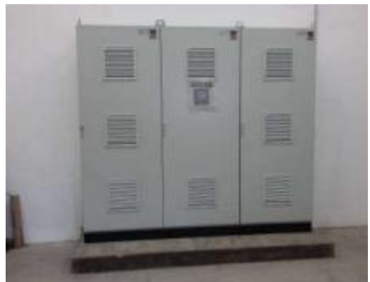
Instalación de banco de capacitores de 660 kvars.
